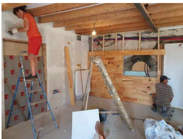
Travaux de construction du bar associatif
